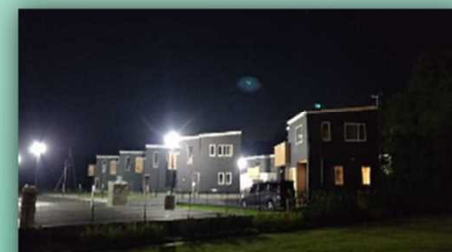
台風被害で停電したが、迅速に復旧した千葉県睦沢市
