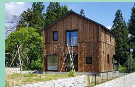
山形県の高断熱省エネ住宅
