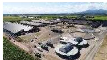
バイオガスプラント
