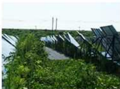
不十分な管理で放置されたパネル
